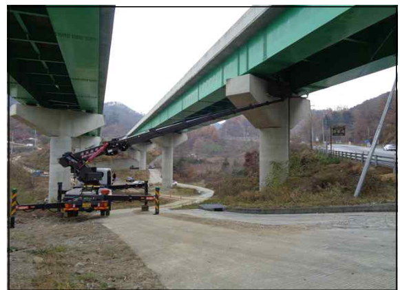
작업차량을 이용한 외관조사
