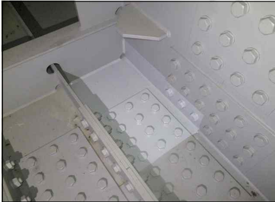
거더 내부 도장보수 현황(S1-G1)
