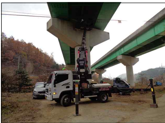
작업차량을 이용한 외관조사
