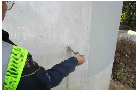
b. 교각 탄산화 시험
