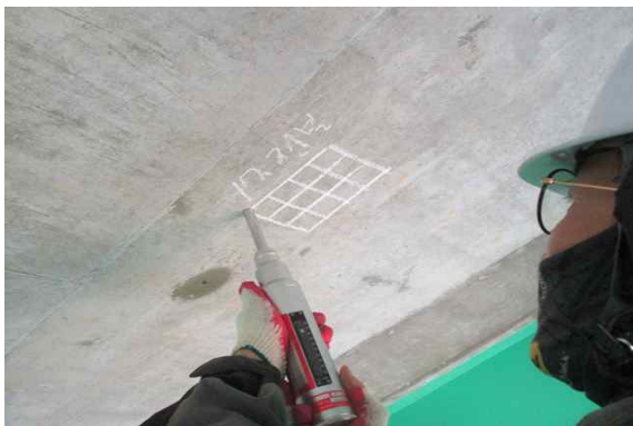
상부구조 바닥판하면 반발경도 측정
