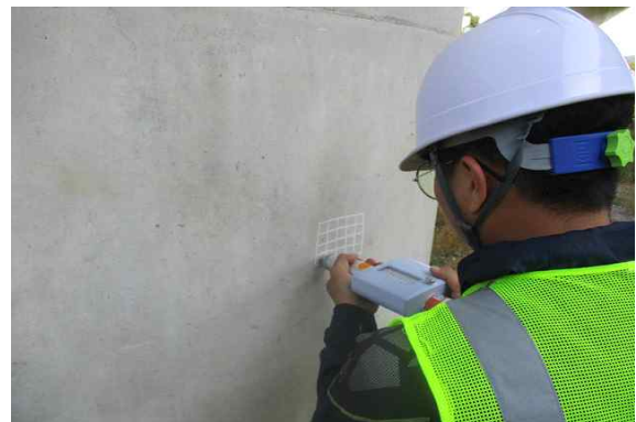
하부구조 교각 반발경도 측정
